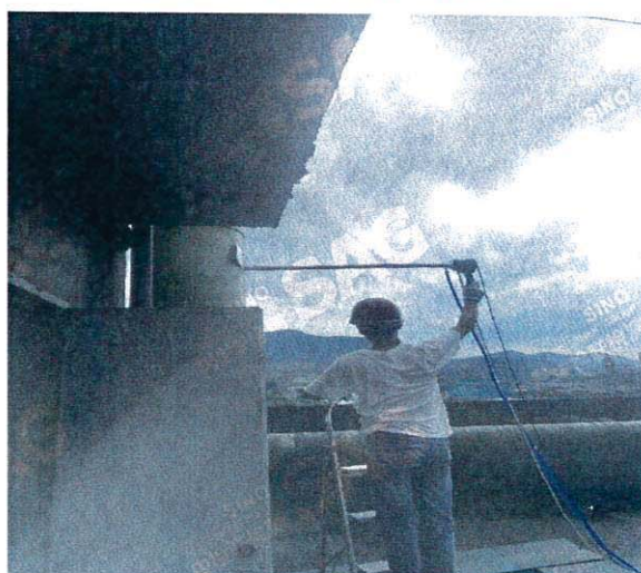
DA032 五车间综合废气排放口
