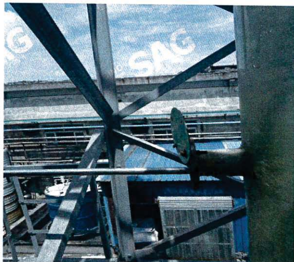
DA035 国际精品园区废水预处理站废气排放口
