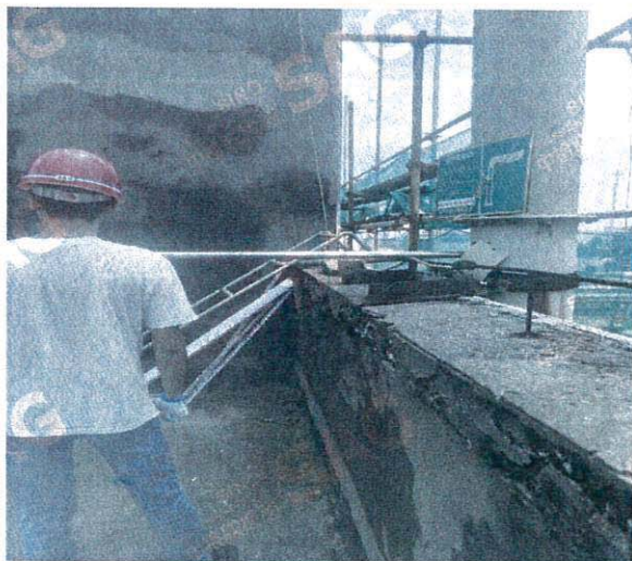
DA037 六车间废气排放口
