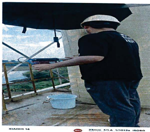
DA044 污水处理站综合废气排放口
